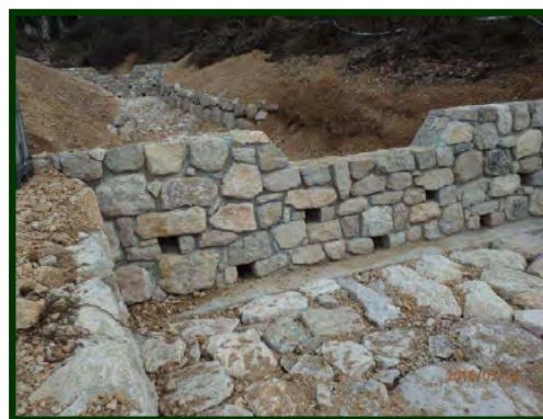
Opere trasversali in gabbioni e muratura a vista
