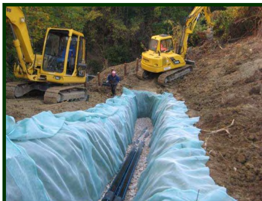
Opere di consolidamento e drenaggi profondi per consolidamento versante in frana
