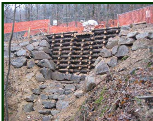
Opere di sostegno
