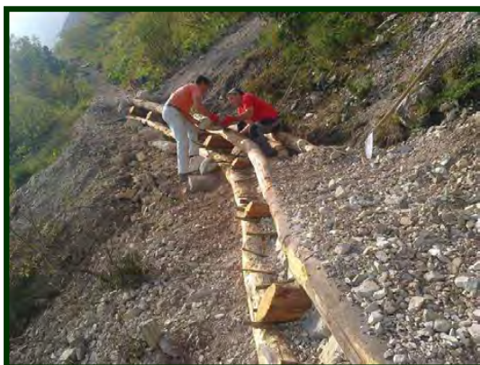
Opere di consolidamento e drenaggi profondi per consolidamento versante in frana
