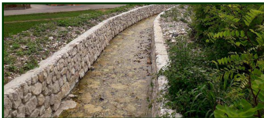
Cunettone in calcestruzzo rivestito in pietrame
