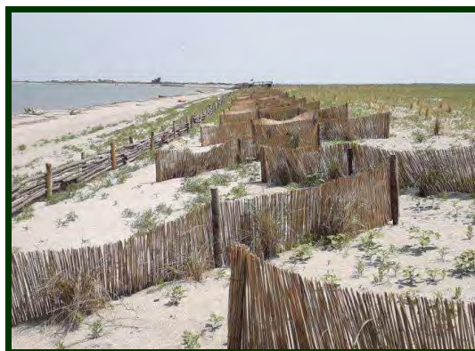
Interventi di consolidamento dune e di stabilizzazione dell'arenile e degli scanni con tecniche di ingegneria naturalistica
