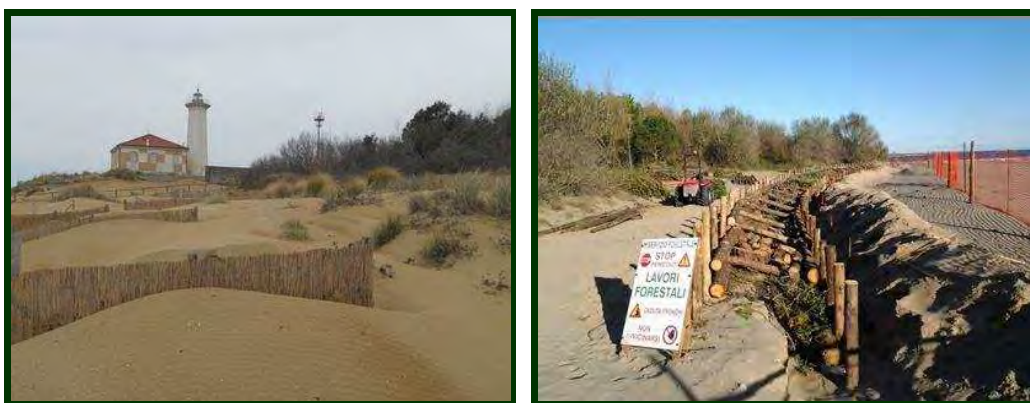
Interventi di consolidamento dune e di stabilizzazione dell'arenile e degli scanni con tecniche di ingegneria naturalistica
