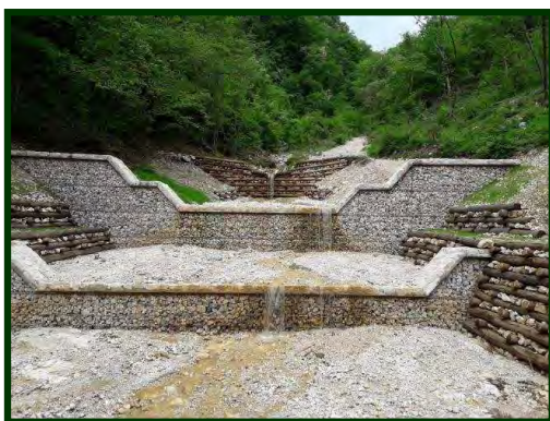
Opere trasversali in gabbioni e muratura a vista
