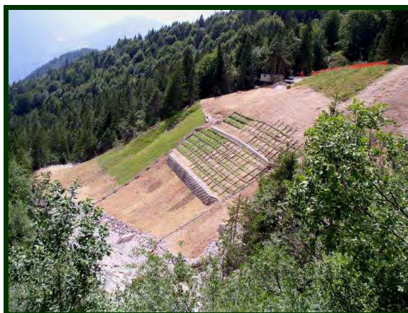
Opere di consolidamento e drenaggi profondi per consolidamento versante in frana
