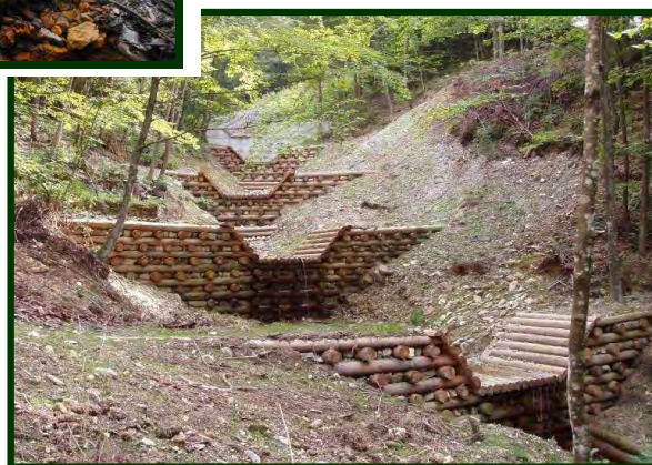
Opere trasversali e longitudinali realizzate con tecniche di ingegneria naturalistica per il consolidamento del fondo dell'alveo e difesa di sponda
